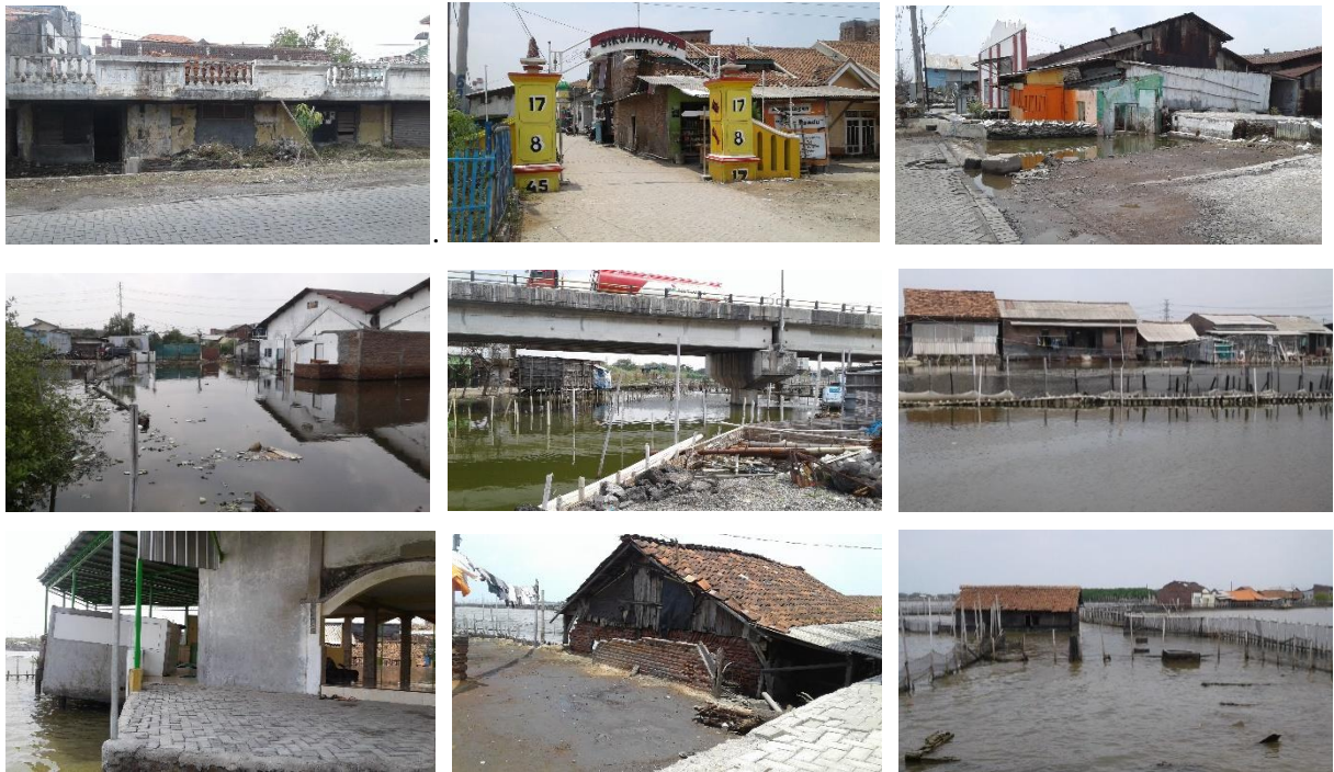
Gambar 2.1. Dampak negatif penurunan konsolidasi tanah di Semarang Utara
