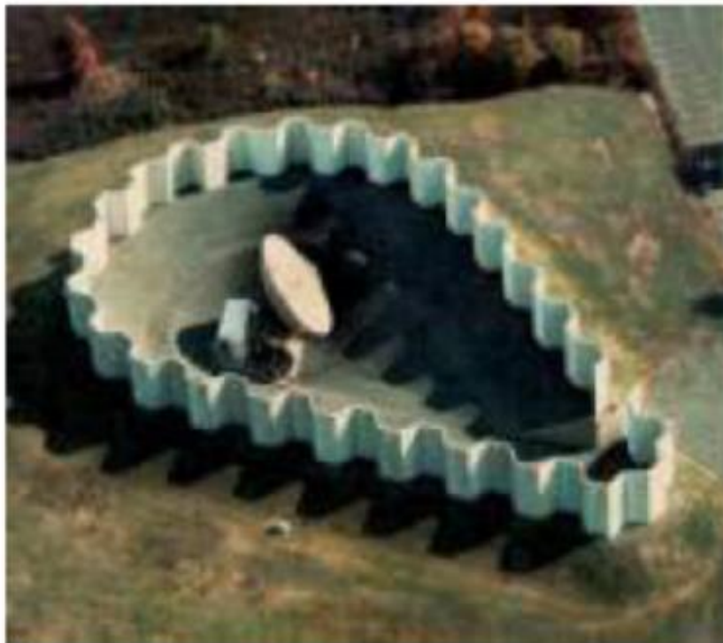
Gambar 4 - Pembangunan Perisai pelindung pada FSS [7]
