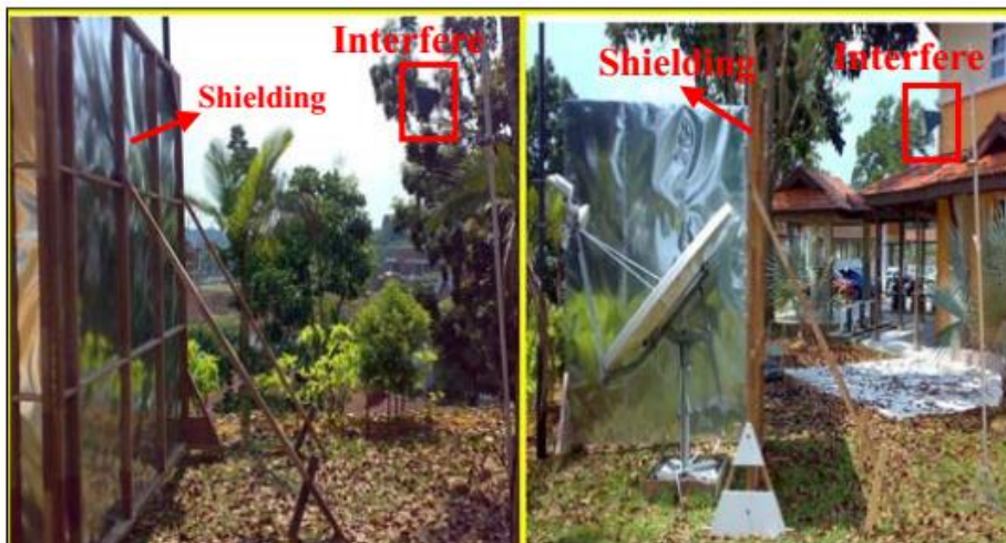
Gambar 5 - Pembangunan Perisai pelindung pada FSS [27]
