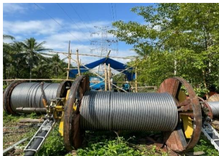
Gambar 2. 3 Konduktor ACSR SUTT 70 kV GI Namlea – GI Namrole
