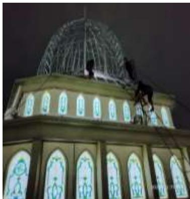
*Gambar 9. Pembuatan Kerangka Pola Kubah masjid*
