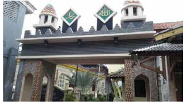
Gambar 25 Sesudah Renovasi Gapura Masjid
