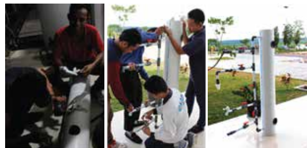
Gambar 6. Proses Pembuatan dan Perakitan Daur Ulang Air Wudu Masjid Baitul Ilmi ITERA
