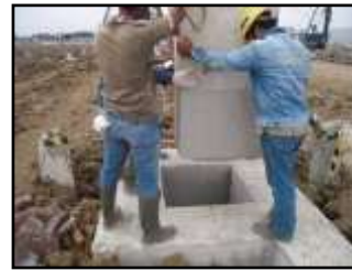
Gambar 2. Pekerjaan Kolom Precast (Sumber: Takenaka Indonesia, 2016)
