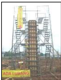
Gambar 1. Pekerjaan Kolom Konvensional (Sumber: Takenaka Indonesia, 2016)
