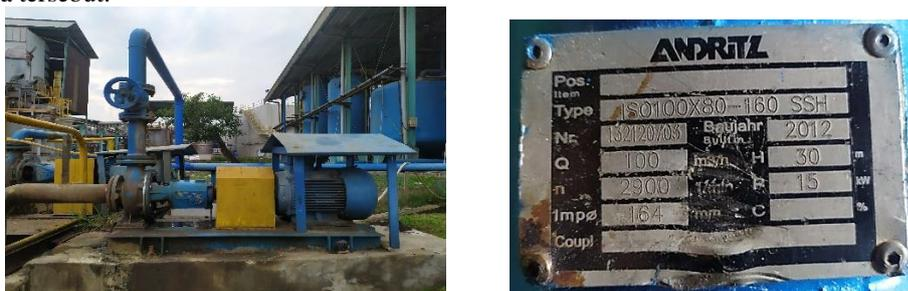
Gambar 2. Pompa dan *Name Plate* Pompa Sentrifugal SP039
