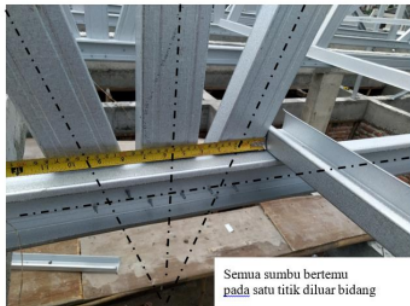
Gambar 2. Sambungan titik buhul menyebabkan eksentrisitas
