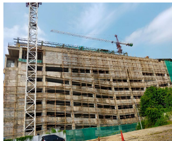
Gambar 3. Proses Konstruksi Cibinong City Mall
