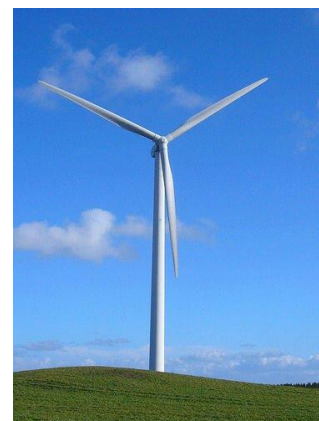
Gambar 1. Pembangkit Listrik Tenaga Angin (PLTB)
