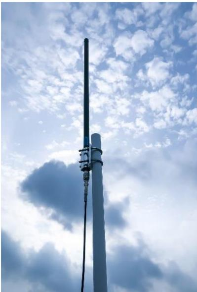
Gambar 19. Pemasangan Antena ADS-B 1090 MHz pada ketinggian 11 meter di atas permukaan tanah
