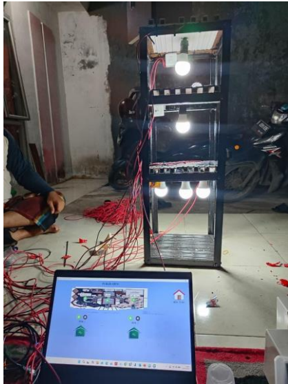
Gambar 5. Percobaan Pengujian Sistem (Kontrol Lighting)
