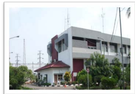
Gambar 2. Gedung Kontrol Gardu Induk Konvensional
