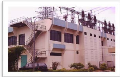
Gambar 4. Gedung Kontrol GIS
