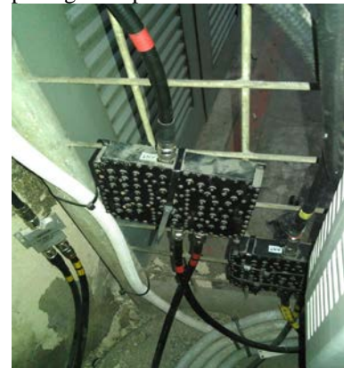
Gambar 13 Penggantian Triplexer
