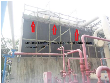
Gambar 16. Kondisi struktur cooling tower
