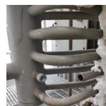
Gambar 1. Pipa LTE yang Telah Diperbaiki
