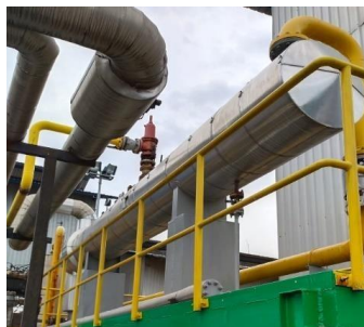
Gambar 2. Alat Penukar Kalor Shell dan Tube HE-101
