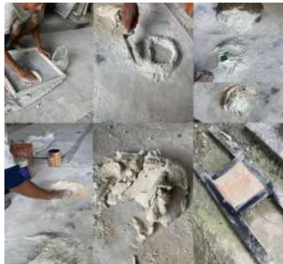
Gambar 6. Proses Percampuran Dengan Semen Putih Sampai Ke Cetak
