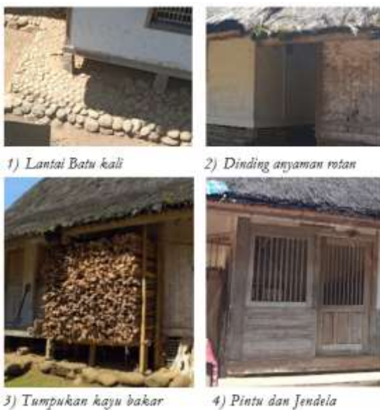
Gambar 5. Elemen Material dan Bangunan di Kampung Sunda yang menginspirasi Area Teras/Bale-bale lokasi Kampung Naga
