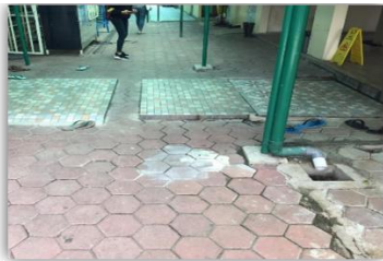
Gambar. 9. Desain Lama (Existing) Jalan Menuju Tempat Wudhu. (Sumber: dok. Sanjaya dkk, 2018).
