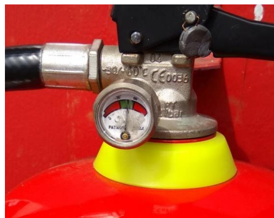
Gambar 3: penunjuk tekanan ( pressure gauge )
