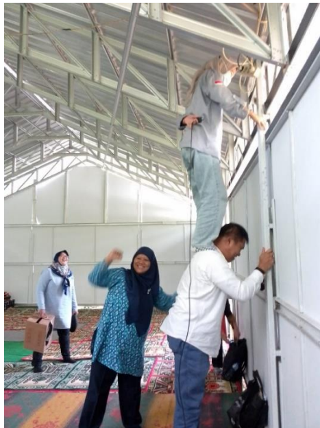
Gambar 6. Tim teknis menyiapkan peralatan dan memeriksa listrik Sumber: pribadi
