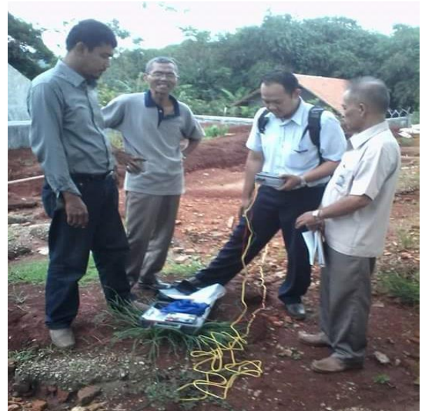
Gambar 12. Pengukuran pentanahan di area cakupan 3
