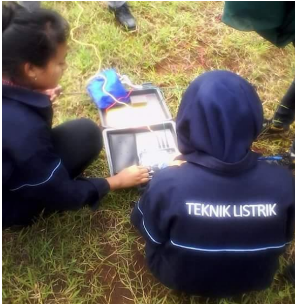
Gambar 10. Pengukuran pentanahan di area cakupan 1
