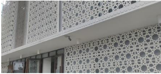
Gambar 4. Awning pada lantai dasar
