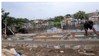
Gambar 7. Pembuatan Septiktank Komunal Sumber : Penulis, 2019
