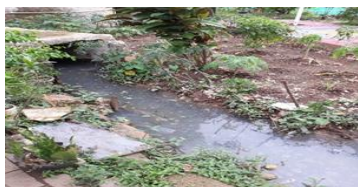
Gambar 5. Kondisi Drainase Sumber : Penulis, 2019
