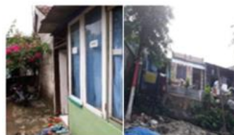
Gambar 3. Kondisi Bangunan Permukiman Sumber : Penulis, 2019
