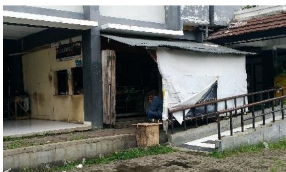
c. Kondisi Material Warung
