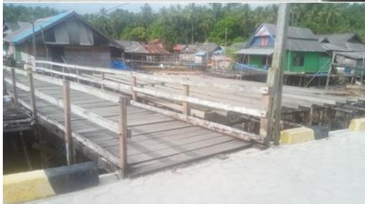
Gambar 5. Eksisting Jembatan Titian Sumber : DokumentasiTim Peneliti, 2022
