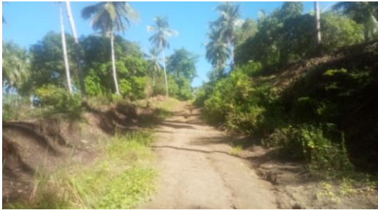
Gambar 4. Eksisting Jalan Penghubung Sumber : DokumentasiTim Peneliti, 2022
