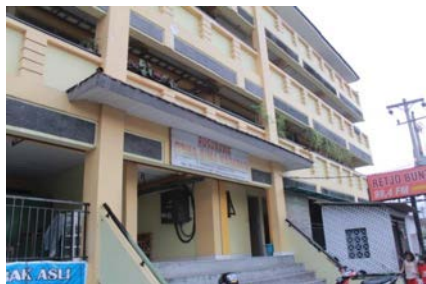
Gambar 2. Fasade depan Rumah Susun Juminahan, Yogyakarta.
