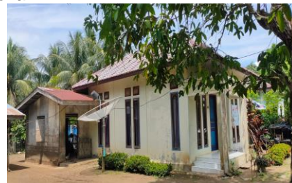
Gambar 6. Salah satu Bangunan tambahan pada bagian belakang hunian dengan menggunakan material lokal.
