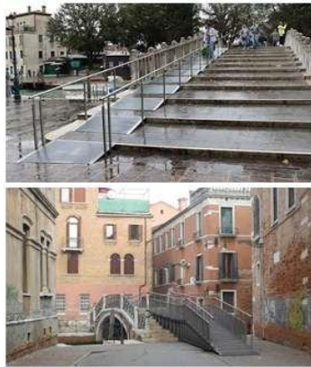
Gambar 7. (a) Ram Pada Jembatan Papadopoli Dengan Pijakan; (b) Ram Pada Jembatan Ognissanti Dengan Pijakan
