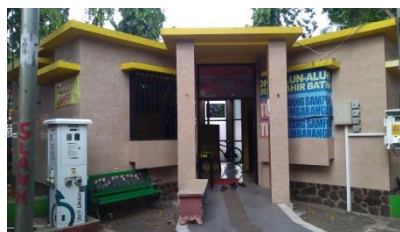
Gambar 22. Kondisi toilet umum Sumber : Penulis, 2023
