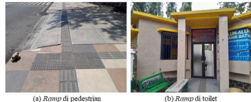
Gambar 17. Kondisi guiding block dan ramp pada toilet umum dan pedestrian Sumber : Penulis, 2023
