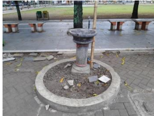
Gambar 15. Kondisi wastafel Sumber : Penulis, 2023
