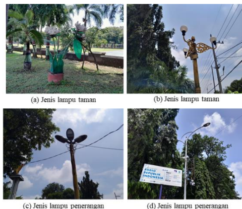
Gambar 14. Kondisi lampu penerangan Sumber : Penulis, 2023
