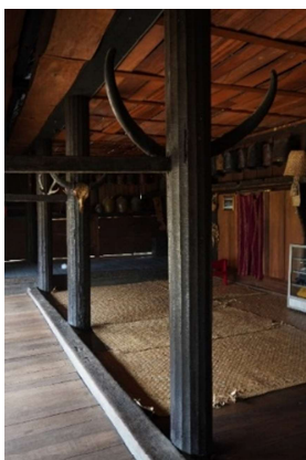
Gambar 18. Bendul tengah yang memisahkan ruang masinding(kiri) dan ruang tengah(kanan) Sumber: Dokumentasi Pribadi, 2023
