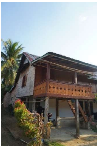
Gambar 10. Rumah R4 tidak memiliki bubungan melebar kesamping dan bentang layar di sisi samping
