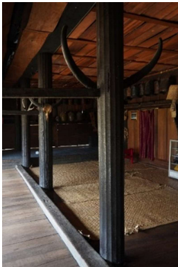
Gambar 13. Kolom dan Bendul Tengah (balok) berbahan kayu besi Sumber: Dokumentasi Pribadi, 2023
