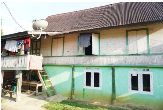
Gambar 9. Rumah R3 tidak memiliki pintu gedang
