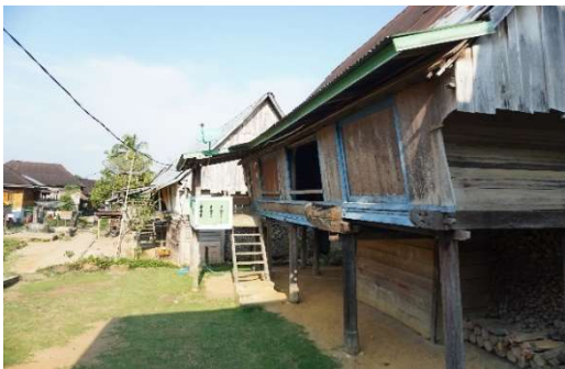
Gambar 7. Dinding miring dan bentang layar pada rumah R7
