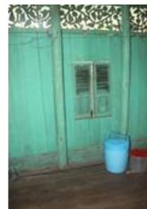
**Gambar 15 Papan dinding yang dipasang secara horizontal**
