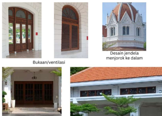
Gambar 7. Bukaan dan ventilasi Gedung Balai Pemuda Sumber : Penulis, 2024
