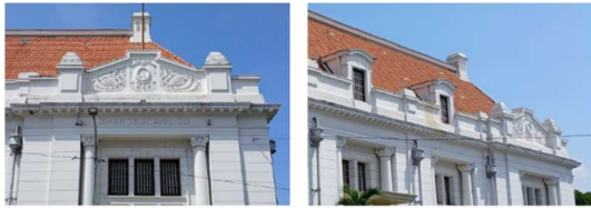
Atap dan talang air hujan
