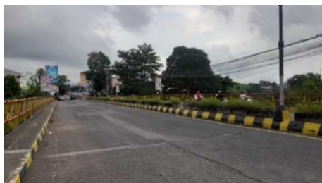
Gambar 17. Kondisi Eksisting Jembatan Gladak Kembar Jember di Sungai Bedadung
