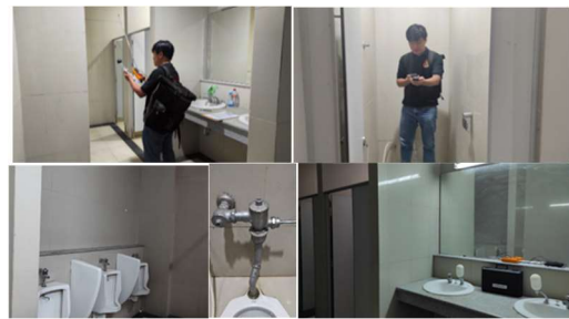
Gambar 4. Kondisi toilet dan WC
