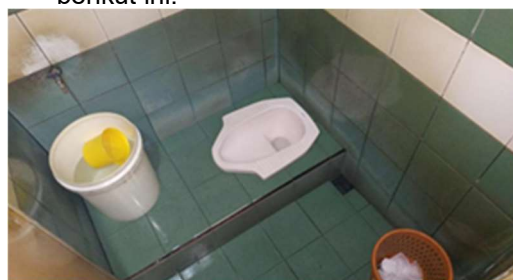
Gambar 12. Terdapat sumber air yang dialirkan ke toilet dan area wudlu (Sumber: Data Pribadi di Lapangan, 2020)
