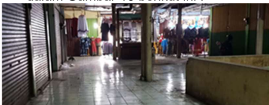
Gambar 16. Bangunan mempunyai minim ventilasi alami, yaitu bukaan pada sisi-sisi luar saja. (Sumber: Data Pribadi di Lapangan, 2020)
