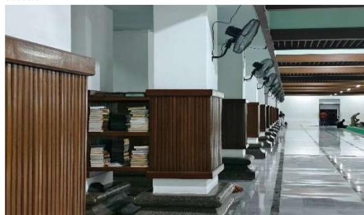
**Gambar 15.** Material Kayu pada Kolom Masjid Sunan Ampel
