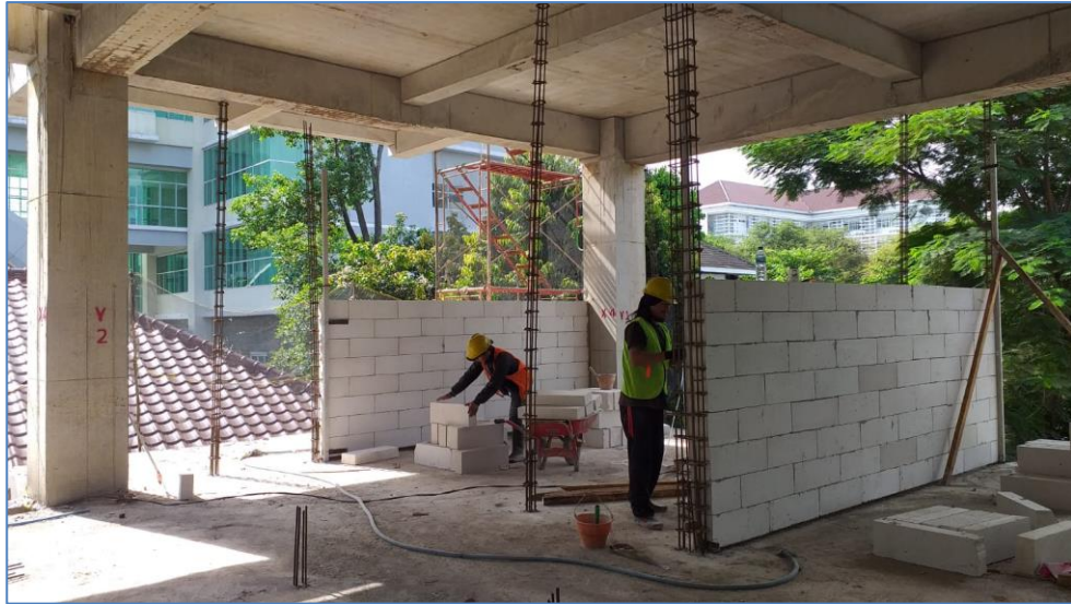
Gambar 10. Progres Pembangunan Hingga Bulan Januari 2024
