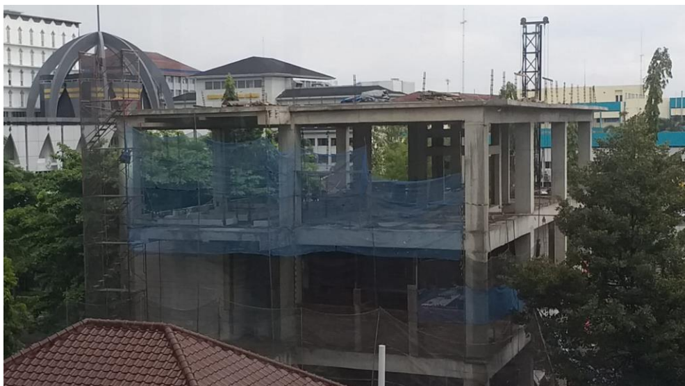
Gambar 8. Progres Pembangunan Hingga Bulan Maret 2024
