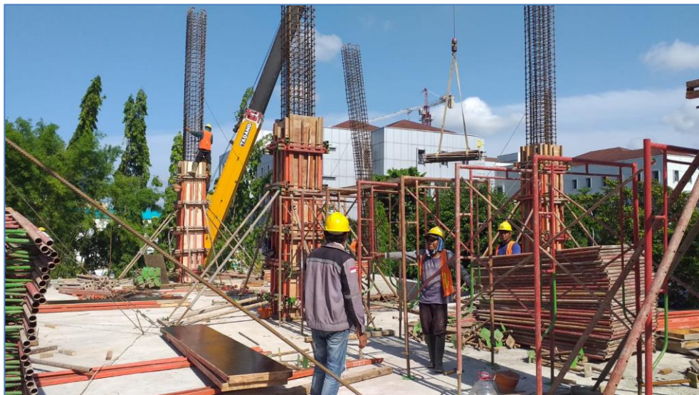
Gambar 9. Progres Pembangunan Hingga Bulan Januari 2024
