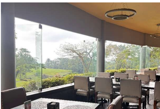
Gambar 7. Bangunan Cenderung Terbuka Tanpa Secondary Skin Sumber : Pribadi, 2025
