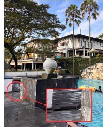
Gambar 8. Retakan Ubin Kolam Renang
