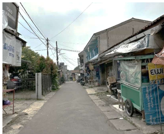
Gambar 1. Kondisi Permukiman Jalan Marga Jaya, Tangerang.
