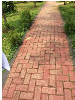
Gambar 5. Jalur pedestrian di RPTRA Akasia menggunakan paving yang di cat Sumber : Peneliti, 2018
