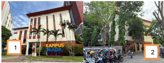
Gambar 5. Foto Bangunan 2 (Gedung F Fakultas Teknik) 1. Tampak depan (Tenggara) 2. Tampak belakang (barat laut),
