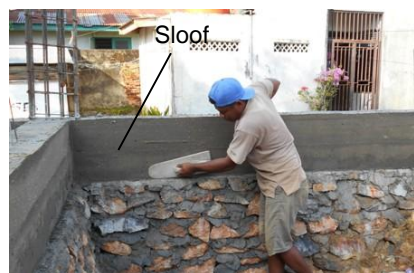
Gambar 1. Sloof pada bangunan Rumah Toko di Kota Kendari
