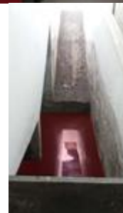
Gambar 6. Gorong-gorong pada sebelah tangga menuju peron
