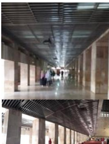
Gambar 4. Bentuk bukaan (pintu) persegi diruang shalat dan koridor lebar sehingga terhindar dari tempas hujan
