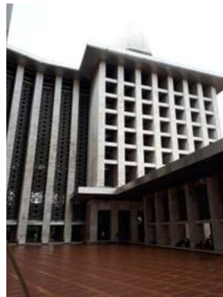
Gambar 6. Jendela/ventilasi yang dibingkai oleh garis-garis vertical dan horizontal
