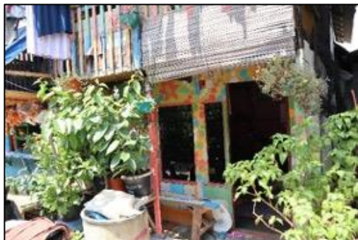
Pemanfaatan sebagai kontrakan:
