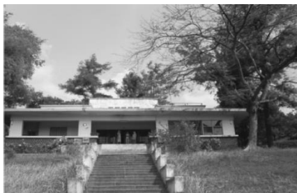
Gambar 3. Bangunan Rumah Sumber : Bambang Setyohadi
