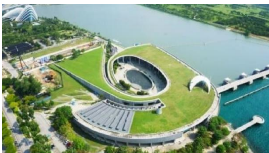
Gambar 7. Marina Barrage, Singapura
