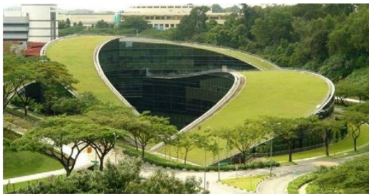
Gambar 6. Penerapan konsep green roof di NTU, Singapura
