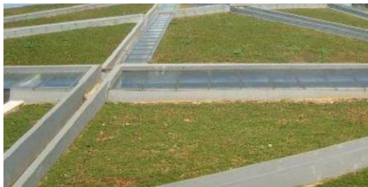
Gambar 3. Sistem drainase dan skylight di perpustakaan UI
